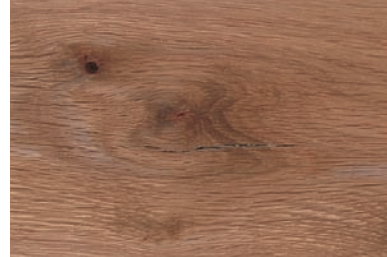
ΣΚΑΣΙΜΟ Επίμηκες άνοιγμα στην επιφάνεια της σανίδας προερχόμενο από ταχύ ή εσφαλμένη ξήρανση
